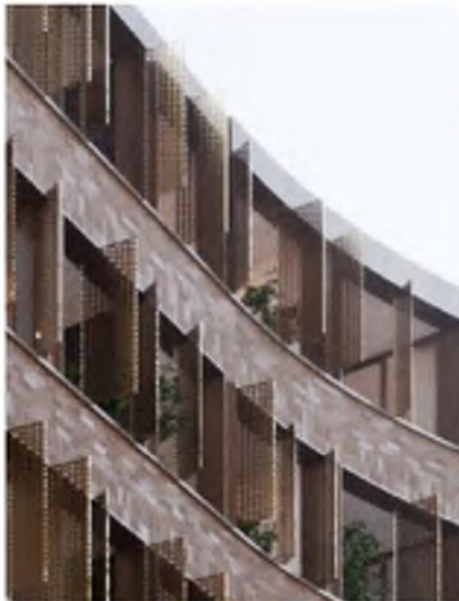
Sun shading vertical mesh fins
